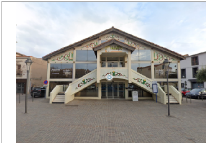
Façade nord-ouest du bâtiment
