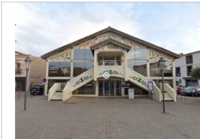
Façade nord-ouest du bâtiment
