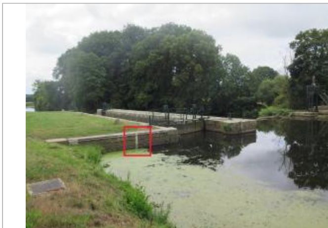
Ecluse de Grenouliere amont à Bréhan
