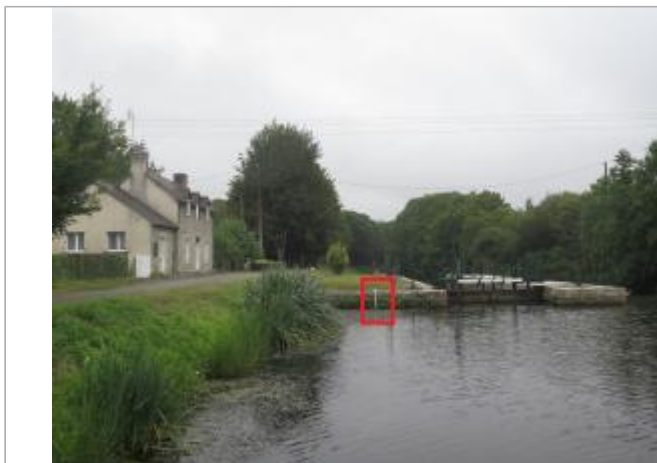
Ecluse de Quenjo amont à Rohan
