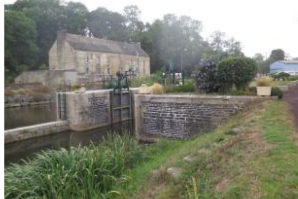
Ecluse de Rohan échelle aval (disparue)
