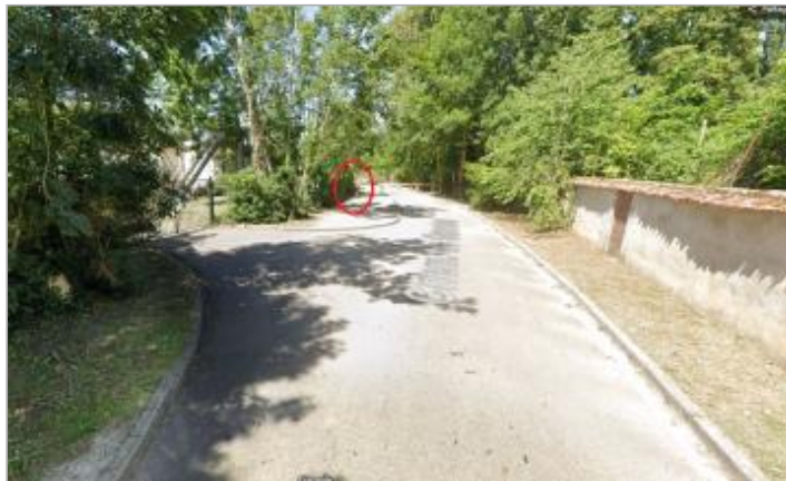
Vue depuis le chemin devant la station d'épuration.
