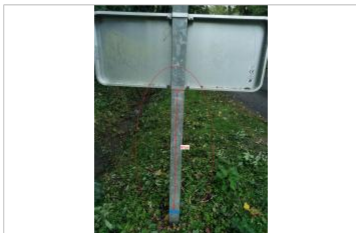
Laisse de crue à 97cm depuis le bas de l'accroche la plus basse du panneau.
