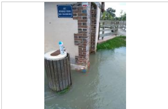
Laisse de crue à 11 cm (vers le bas) depuis le haut du parement (base du lavoir)
