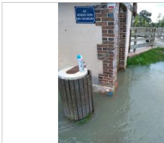
Laisse de crue à 11 cm (vers le bas) depuis le haut du parement (base du lavoir)
