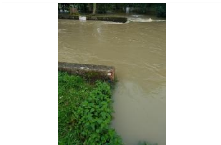
Laisse de crue à 27 cm/haut du muret.
