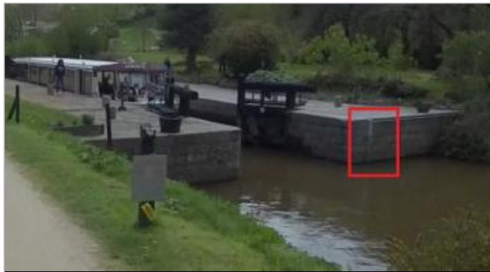
Aval de l'écluse de Léhon à Lanvallay
