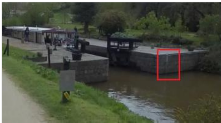
Aval de l'écluse de Léhon à Lanvallay
