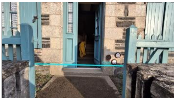
Laisse de la crue de 2025 sur la façade de la maison éclésièrre - photo Conseil Régional de Bretagne - voies navigables
