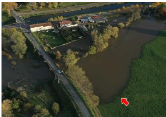
Photographie prise par drone le 15/11/2023 à 17h17
