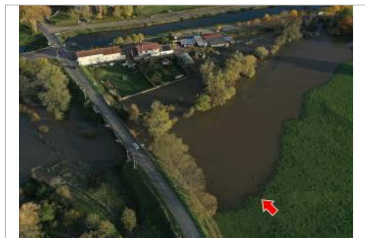
Photographie prise par drone le 15/11/2023 à 17h17
