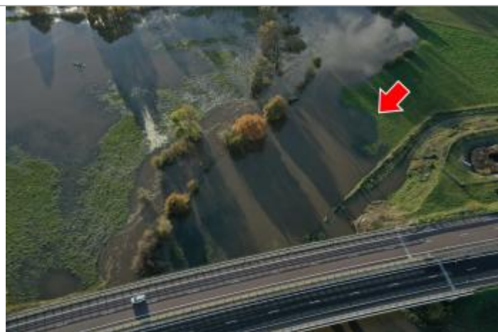
Photographie prise par drone le 15/11/2023 à 17h11
