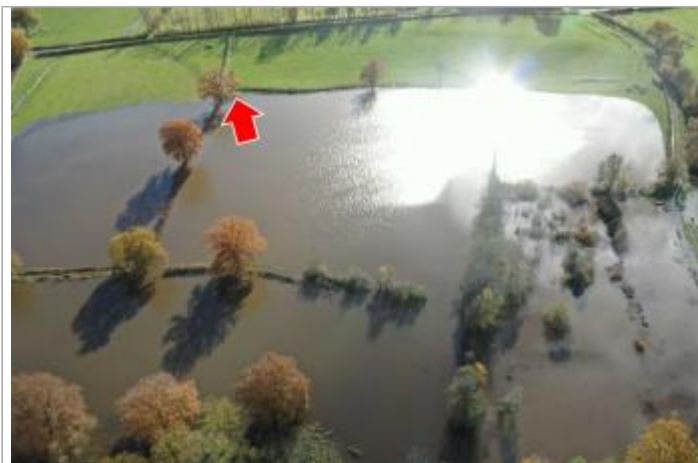
Photographie de l'inondation prise par drone le 15/11/2023 à 14h13
