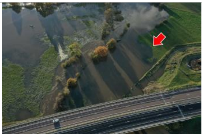
Photographie prise par drone le 15/11/2023 à 17h11
