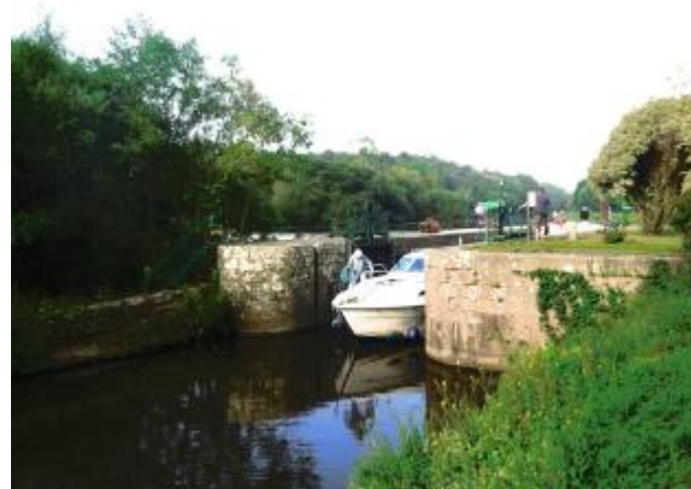
Ecluse de Clan aval à Guillac
