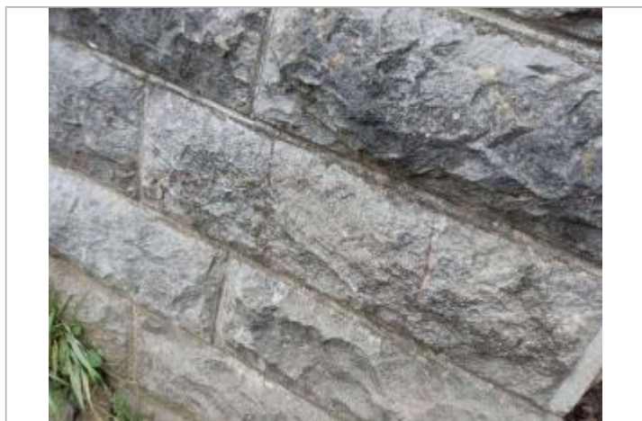
laisse de crue sur pile de pont côté aval
