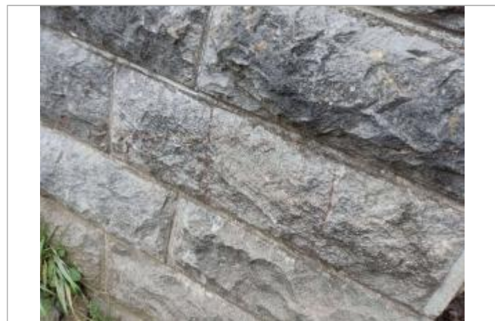
laisse de crue sur pile de pont côté aval
