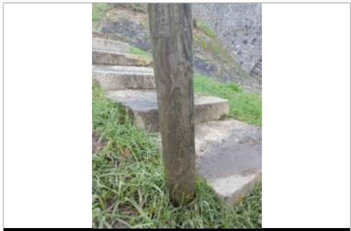
laisse de crue sur poteau près de l'escalier en aval du pont
