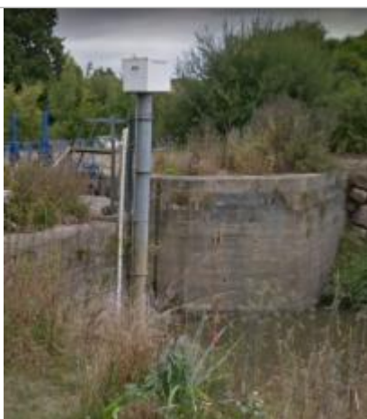
Echelle limnimétrique Aval de l'écluse de Malon
