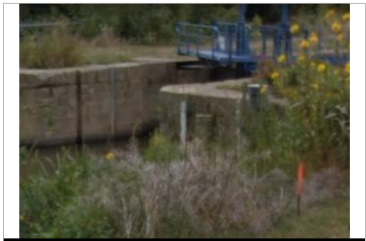
Echelle limnimétrique Amont de l'écluse de Malon
