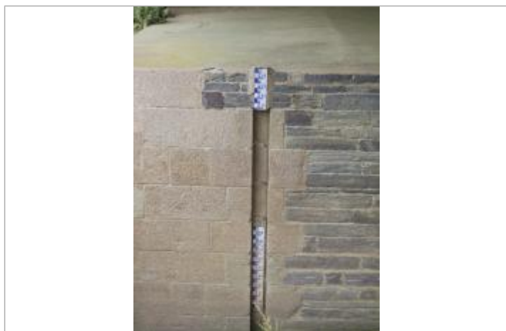
Echelle limnimétrique aval de l'écluse de Guipry sous le pont de la RD 772
