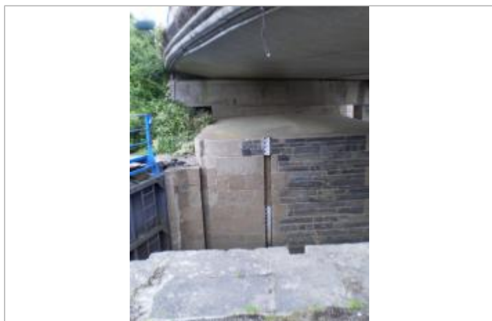
Echelle limnimétrique aval de l'écluse de Guipry sous le pont de la RD 772
