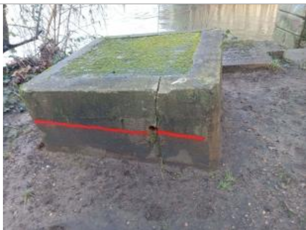
marquage de la laisse de crue à la peinture
