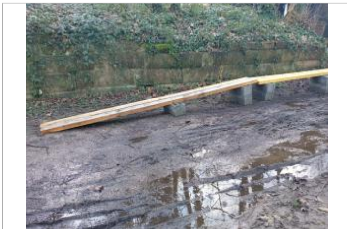
état du site le jour de la visite (05/02/25)
