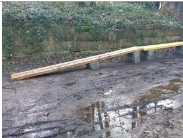
état du site le jour de la visite (05/02/25)
