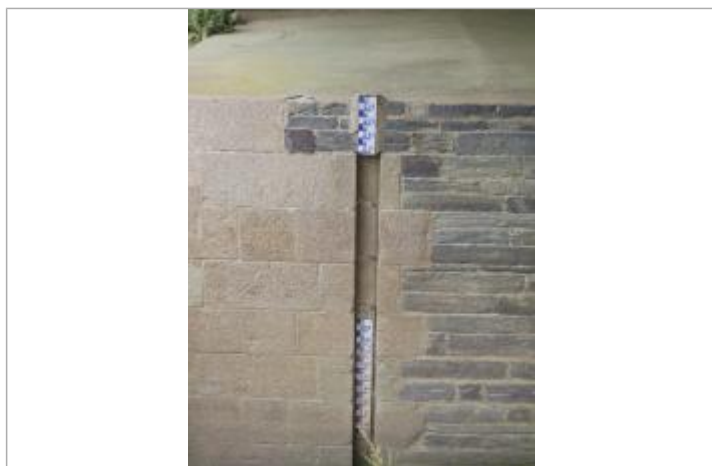
Echelle limnimétrique aval de l'écluse de Guipry sous le pont de la RD 772
