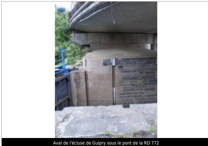
Aval de l'écluse de Guipry sous le pont de la RD 772
