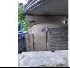
Echelle limnimétrique aval de l'écluse de Guipry sous le pont de la RD 772
