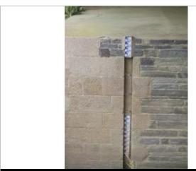
Echelle limnimétrique aval de l'écluse de Guipry sous le pont de la RD 772
