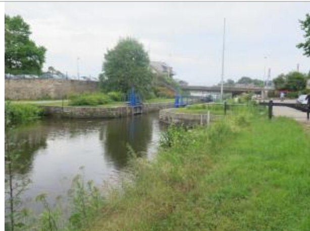
Vue générale du site à l'amont de l'écluse de Guipry
