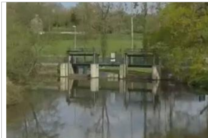
Aval vannage de Boutron
