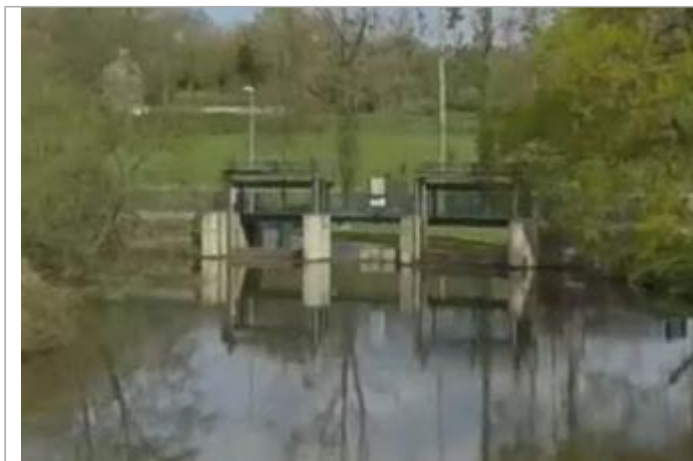
Aval vannage de Boutron
