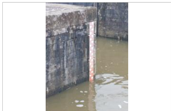
laisse de crue sur l'aval de l'écluse, avec échelle limnimétrique
