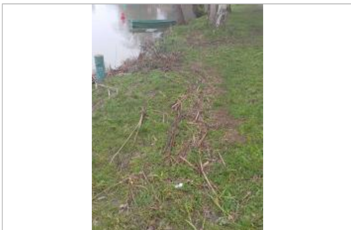
laisse d'inondation constituée de débris
