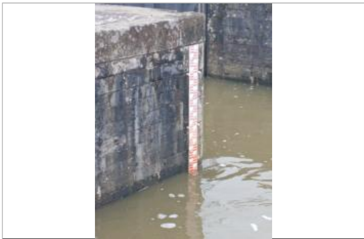
laisse de crue sur l'aval de l'écluse, avec échelle limnimétrique
