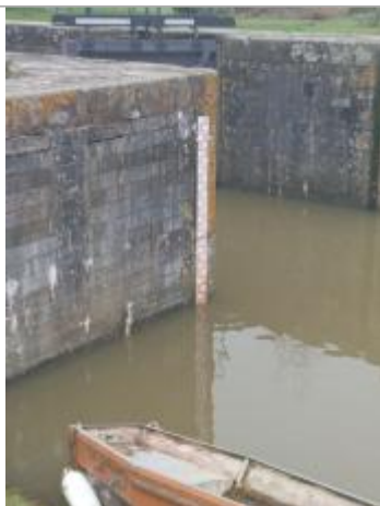
laisses de crue en aval de l'écluse de Solesmes, présentes sur l'échelle de l'écluse.
