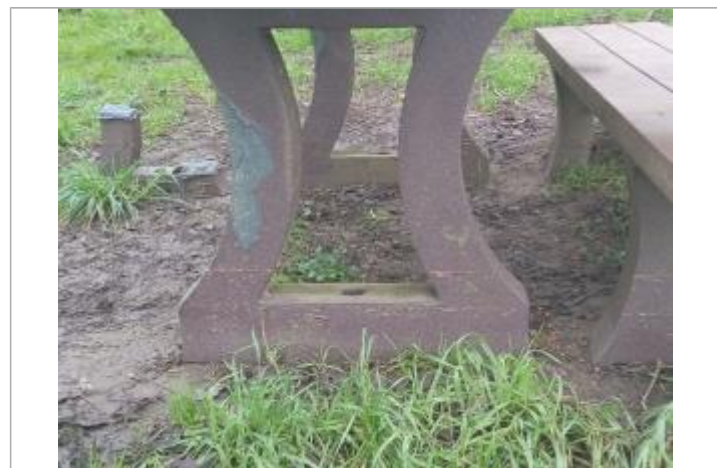
laisses de crue observées
