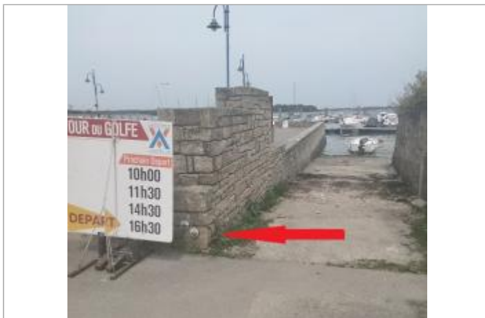
Muret quai Gerry Roufs le 29 mai 2026
