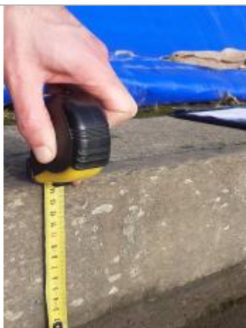
Laisse de crue à 15 cm sous le sommet de la marche supérieure - photo Caen la mer
