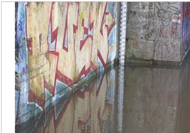
Laisse de crue à 0,43 m en lecture sur l'échelle de crue - photo Caen la mer
