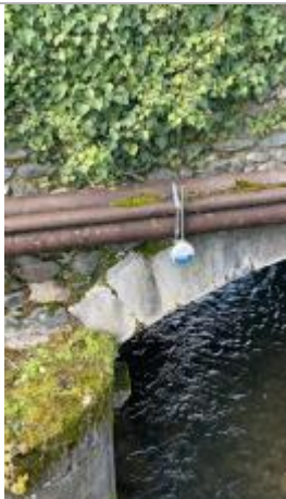
Repère - pont de Lée
