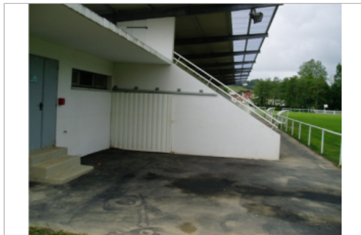
Vue du site
