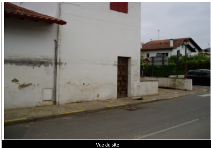
Vue du site
