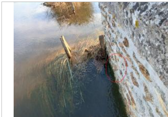
Laisse sur le mur du pont.
