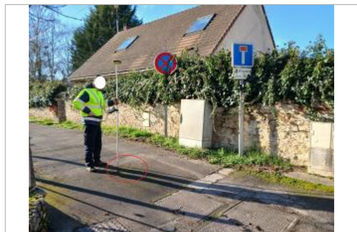
Laisse de crue au sol.
