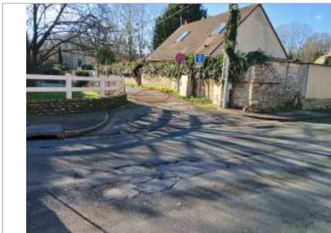
Vue depuis la rue des Arches.
