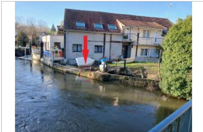
Vue depuis le pont de la rue de Paris
