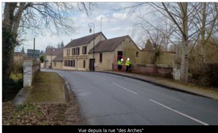
Vue depuis la rue "des Arches"
