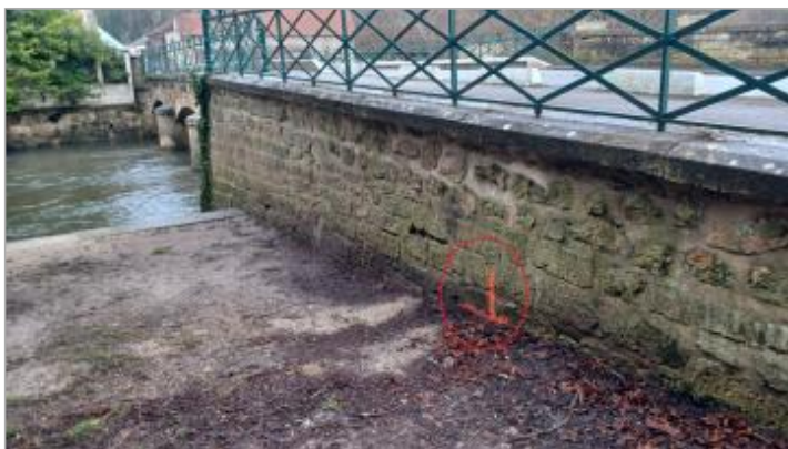
Laisse de crue au sol (au pied du mur de soubassement).
