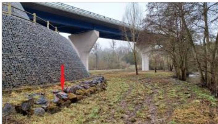
Vue depuis l'amont de la rive gauche.
