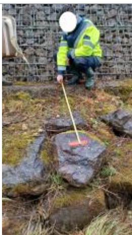
Laisse de crue à 97 cm du haut de l'enrochement.
