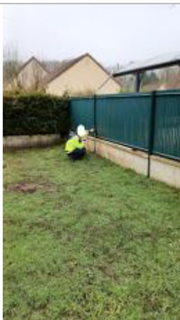
Laisse de crue à 32 cm/sol.
