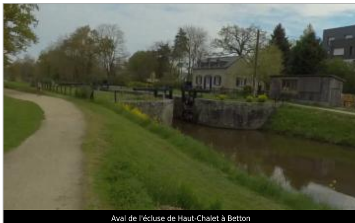
Aval de l'écluse de Haut-Chalet à Betton
