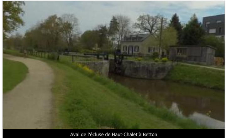
Aval de l'écluse de Haut-Chalet à Betton
