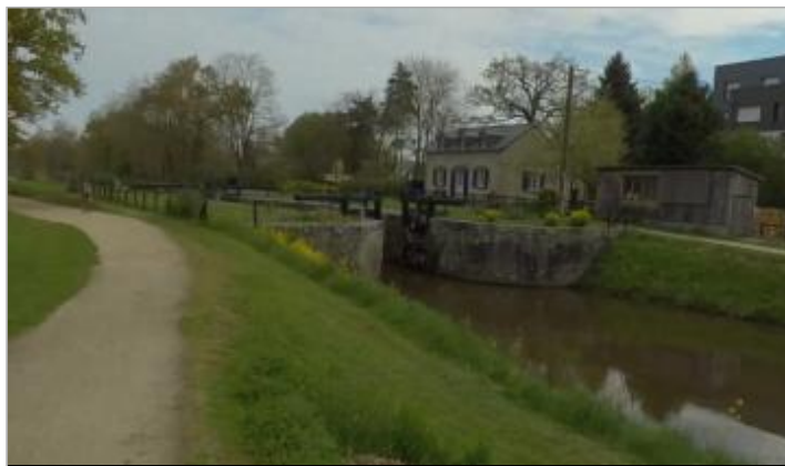
Aval de l'écluse de Haut-Chalet à Betton
