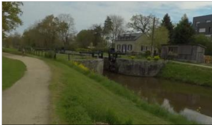
Aval de l'écluse de Haut-Chalet à Betton
